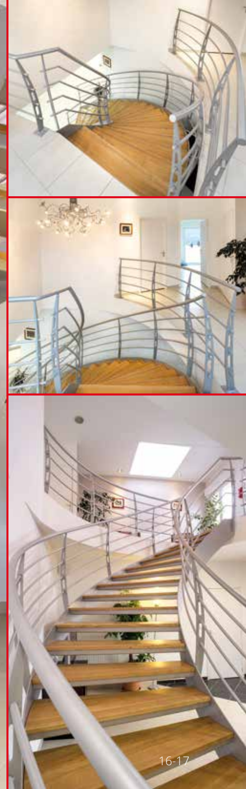
Escalier débillardé à limons latéraux en fer plat. Marches en chêne sur caissons acier. Garde-corps (R21) 4 sous-lisses sur montants personnalisés. Finition en acier peint. ORMES 51
